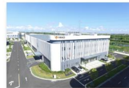
明珞上海临港工厂
