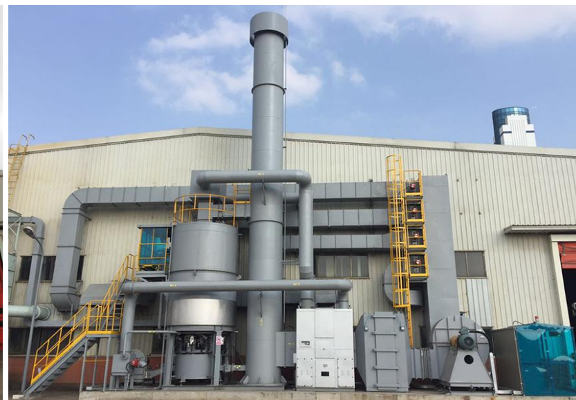
企业：力至优叉车(上海)有限公司（涂装） 风量：浓缩 48,000 + RTO 3,600 Nm 3 /h
