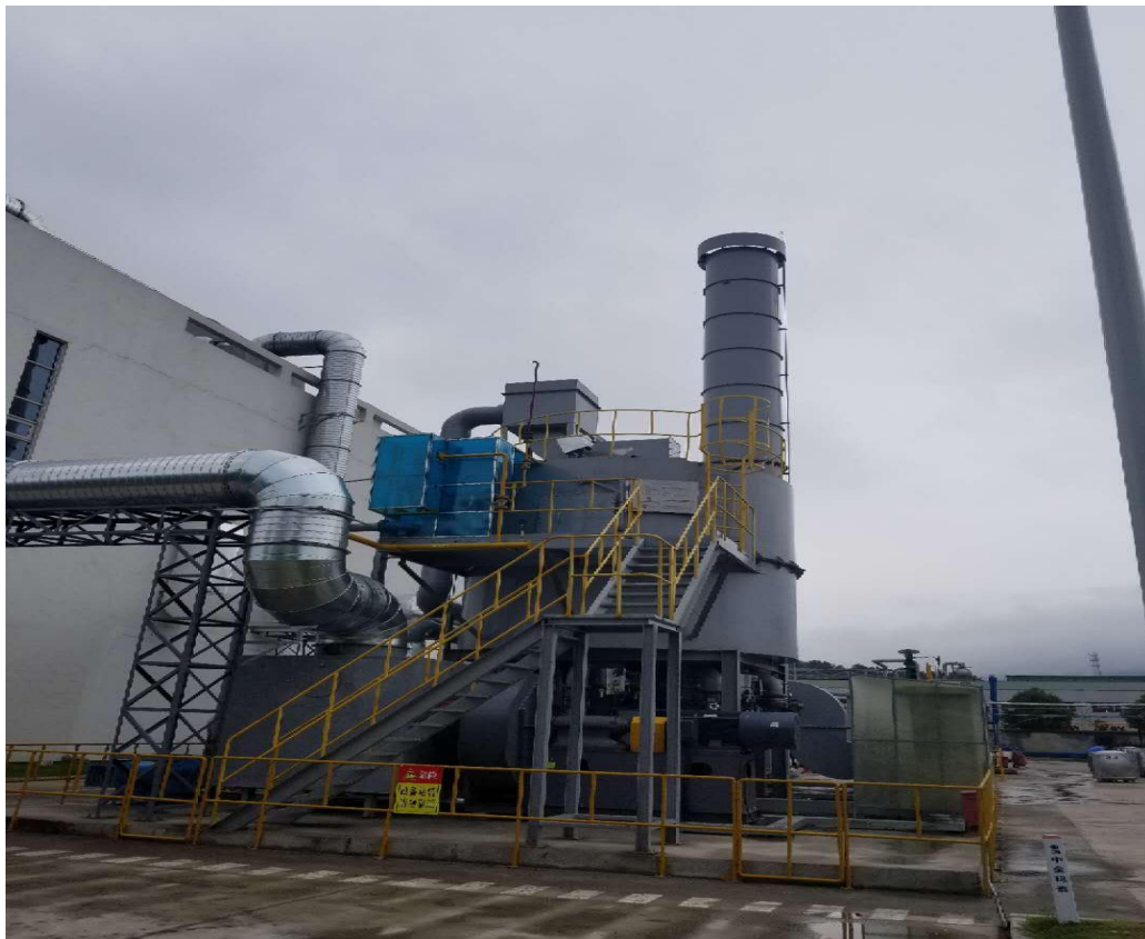
企业：江苏中金玛泰医药包装有限公司 风量：RC 110,000Nm 3 /h + RTO 27,000Nm 3 /h
