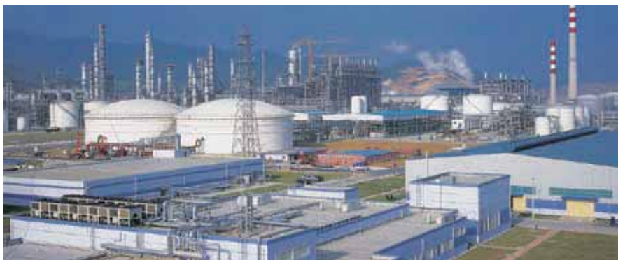
中海壳牌项目
