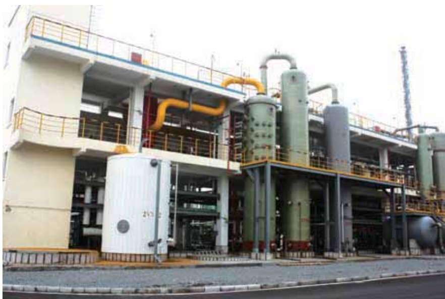
镇洋化工工厂内参观
