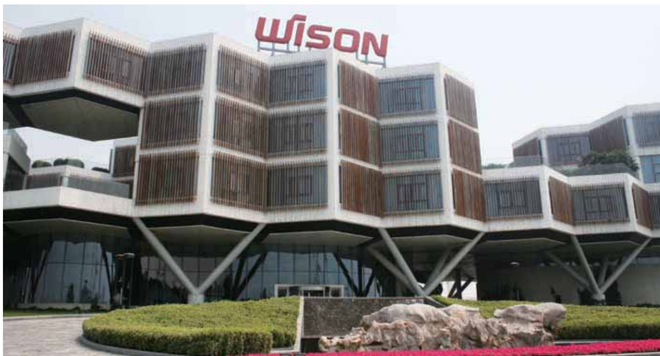
惠生（南京）能源股份有限公司独特的苯环结构的办公楼
