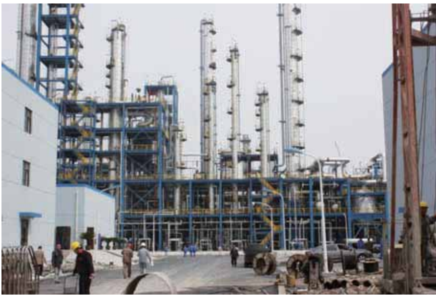
江宁化工在建的顺酐项目
