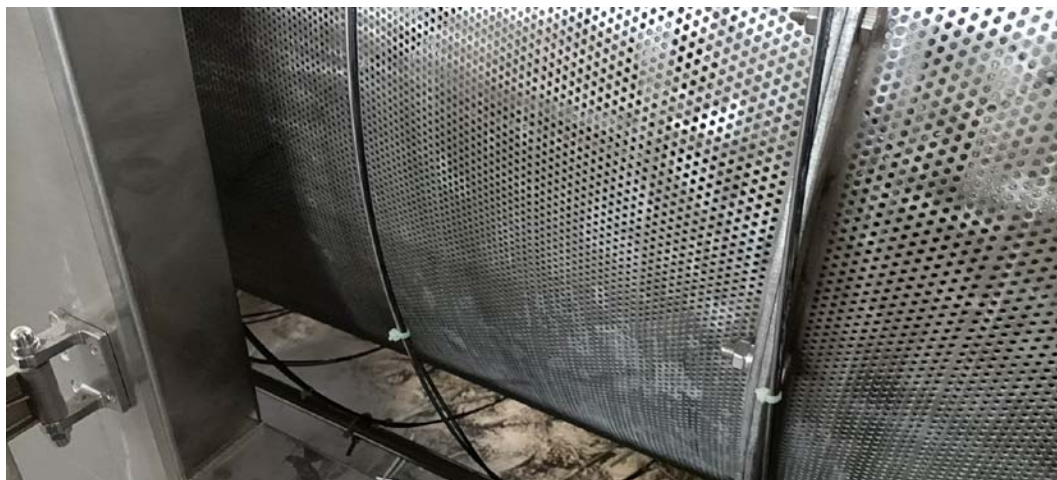
测温光纤安装示意图
