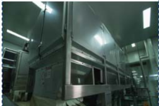
一体化药材前处理
