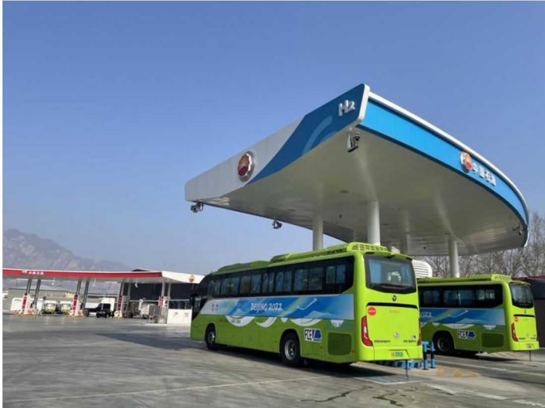
图 58：中石油金龙加氢站，1000Nm 3 /h,70MPa
