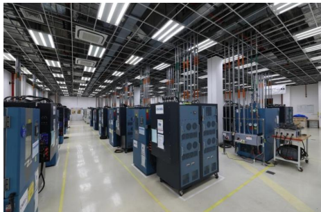
动力电池装配线
