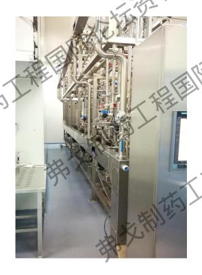
所有的设计纯蒸气和CIP液不能仅有一个隔断阀与物料 管道的隔段。
