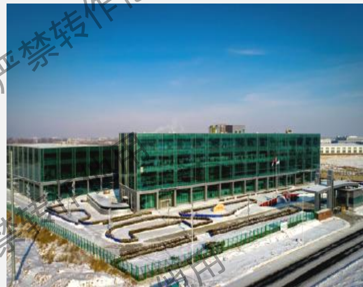
长春钻智制药有限公司生产研发中心项目
