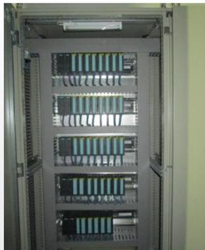
控制系统采用西门子CPU416-5H冗余系统。基于标准S7-400模板的S7-400H是一个冗余的PLC，可以明显地减少生产过程的故障停机率，容错性是通过二个并行的中央控制器实现的。它们的CPU通过光缆连接并通过冗余的PROFIBUS DP线路对I/O进行控制。当CPU故障或PROFIBUS线路故障时进行无扰动的切换，即未受影响的热备控制器将在中断点继续执行控制而不丢失任何信息。
