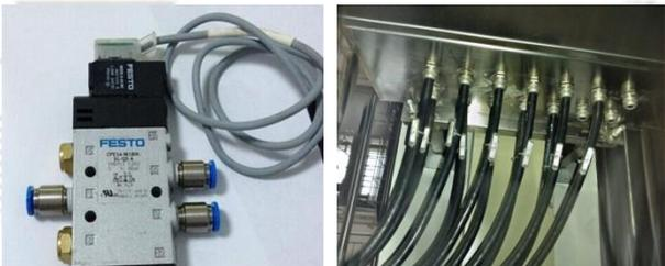
以往项目现场所有气动阀门全部开关量控制，每一个电磁阀都要配置一颗线缆，接线复杂，施工时需要大量人工。
