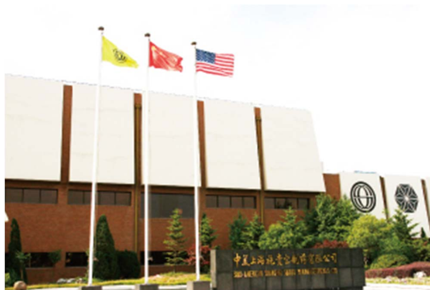
中美上海施贵宝制药厂房改造 上海
