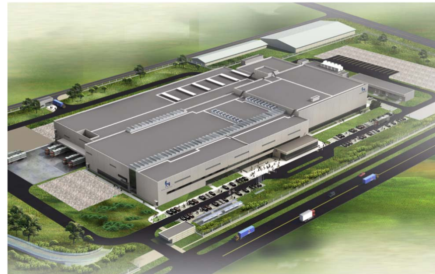
诺和诺德中国制药厂房 天津
